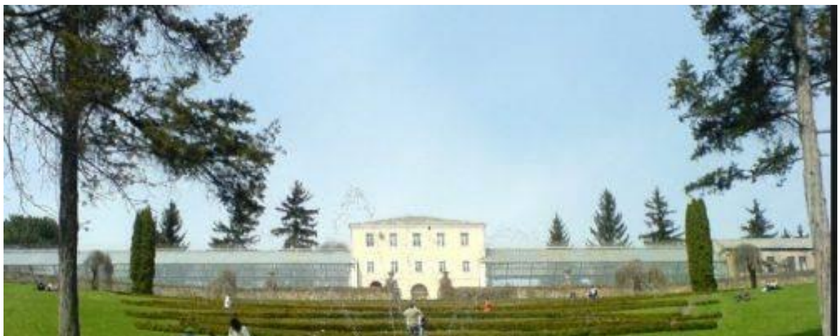
Сучасний вигляд Літнього будинку з оранжереями (ліворуч і праворуч від будівлі оранжереї)
